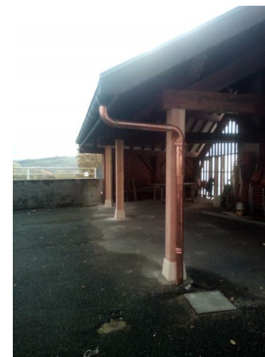
Réfection du toit du préau de l'ancienne école
